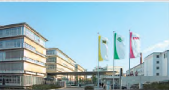
设在德国黑措根奥拉赫的舍弗勒集团总部
